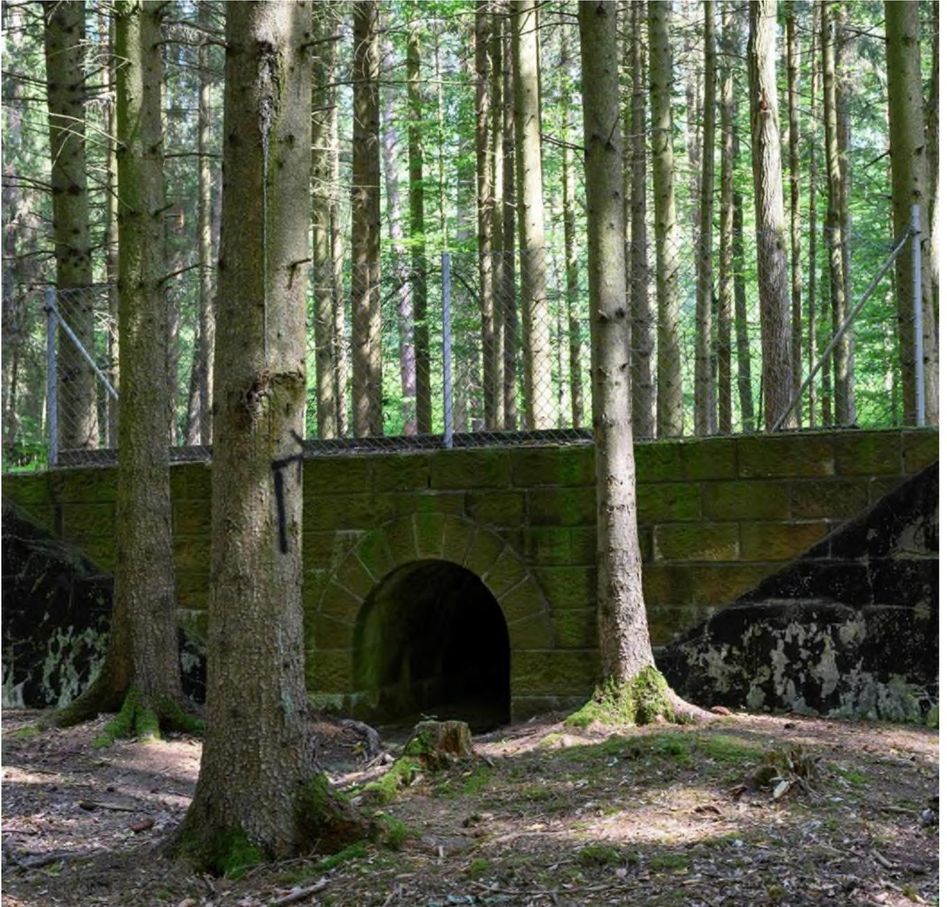
Eine Entwässerung für die geplante Reichsautobahn von Würzburg nach Fulda
